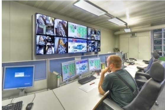
Neue Leitwarte im Presswerk in Bremen
